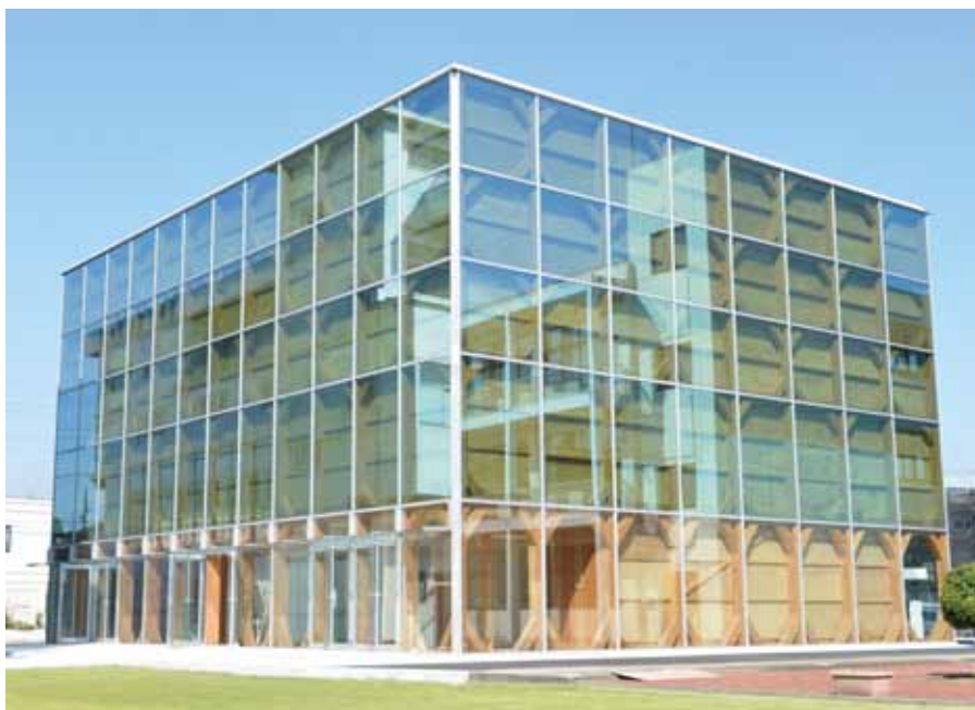
新木造校舎外観
