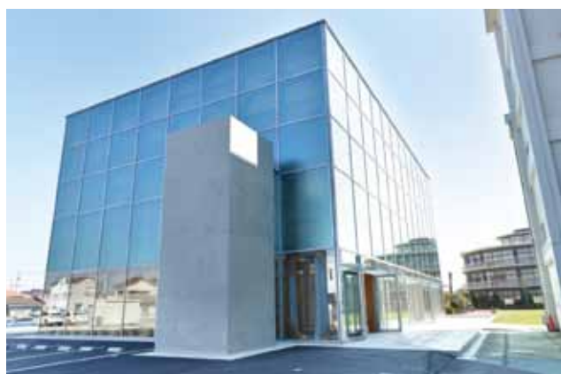
西門側にエレベーターを設置しました
